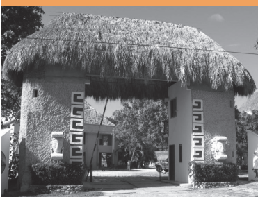
Construction d'hôtels de luxe à Palenque. Photo: Kerkeling
